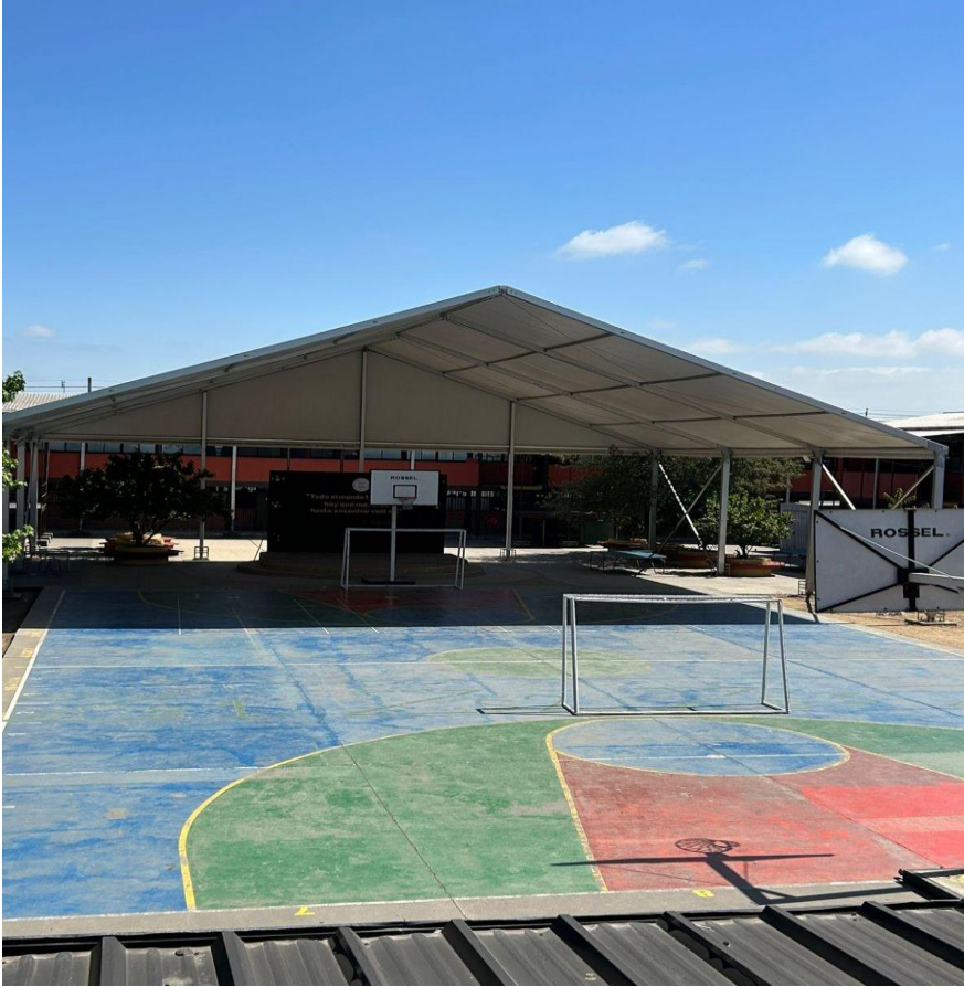
Fotografía Zona de Seguridad
